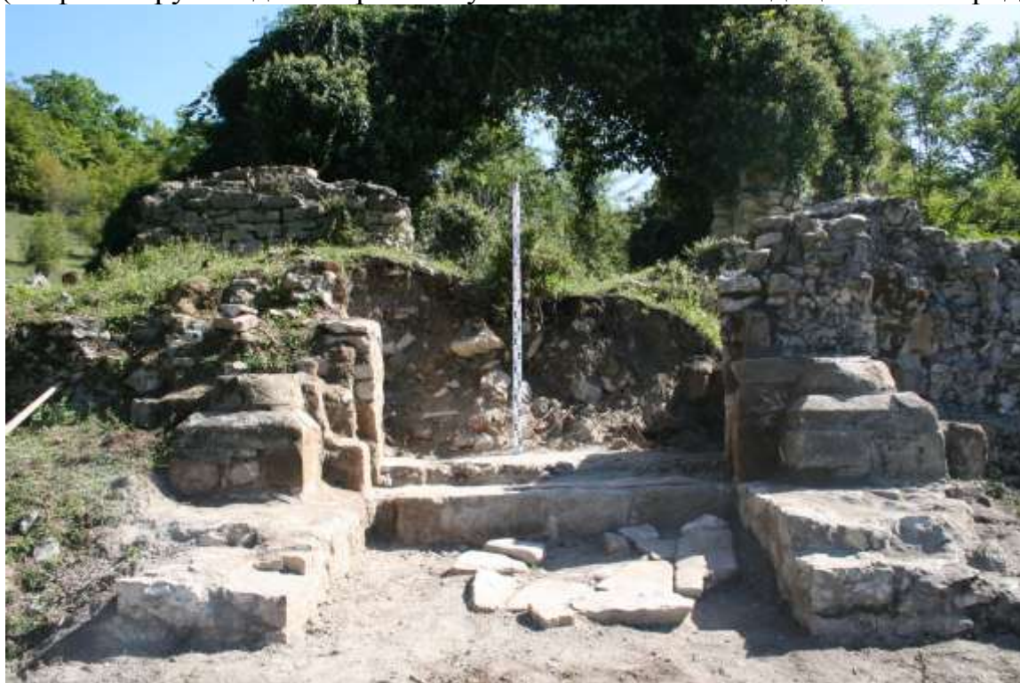
расчистка входа в храм
